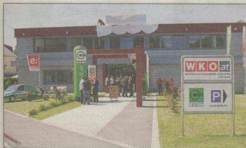
In den WK-Standort Wolfsberg wurden 1,5 Millionen Euro investiert. Jetzt bieten WK und WIFI modernste Ausstattung und spezielle Ausbildungsmöglichkeiten. Auch eine Strom-Tankstelle wurde installiert.
